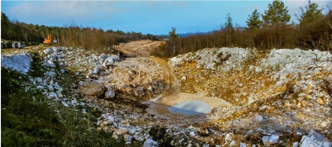
Ang diversion ng isang maliit na kalsada sa paligid ng dolines, tulad ng ipinapakita sa itaas, ay isang simple at epektibong diskarte, gayunpaman, ang mga pangunahing highway ay kinakailangang maging tuwid hangga't maaari. Ang larawang ito ay nagpapakita ng isang doline sa ruta ng isang motorway sa pamamagitan ng Slovenia. Ang doline ay nahukay at ang labasan ay selyado bago ang maingat na pagpuno ng pinagsama-samang upang mabawasan ang panganib ng pagbagsak. Larawan ni John Gunn.
