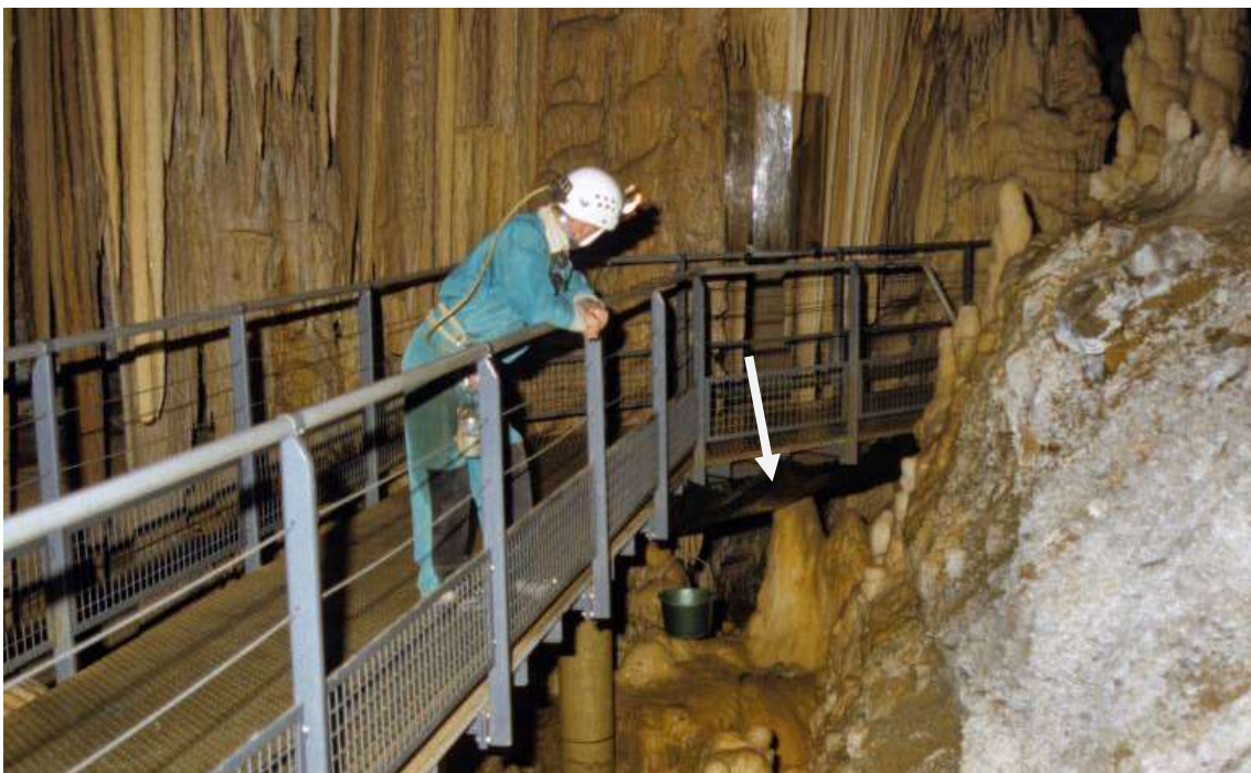
フランス、Gouffre d'Esparros の観光洞にある高くなった通路。矢印は、土砂が下の洞窟に落ちるのを防ぐためのネット。写真：John Gunn.
