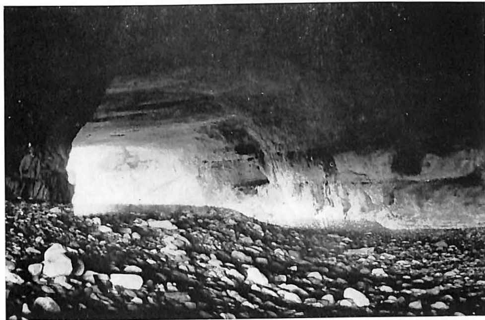
GRAND TUNNEL DE MINERVE Vue intérieure vers l'amont.
