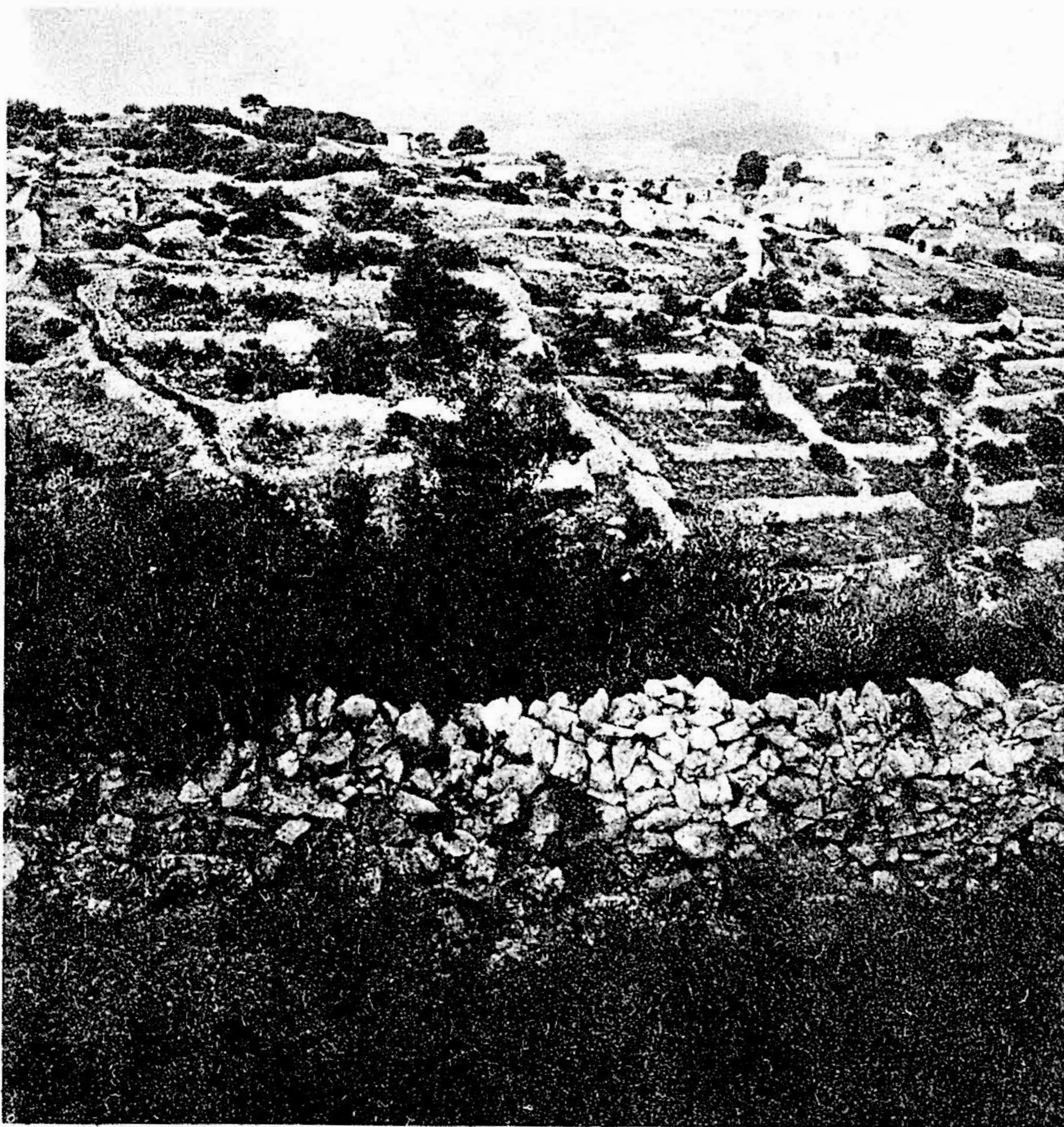
Abb. 4. Die Mauerlandschaft östlich von der kleinen Stadt Mali Lošinj (Quarnärinsel Lošinj, 1973) war dem Olivenbau gewidmet. Das Gewicht der Steine, die in den Mauern stecken, beträgt hier mehrere Hundert Kilogramm pro m 2 der Gartenoberfläche.
