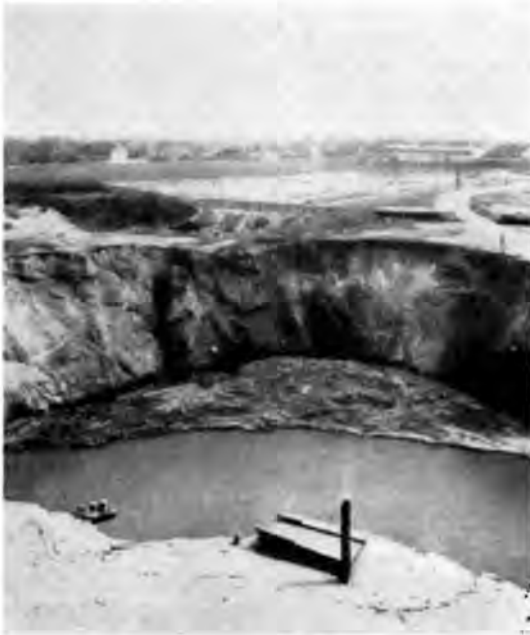
Abb. 5. Erdfallpinge über einem alten ersoffenen Kalischacht bei Wester- egeln (Foto Kammholz)
