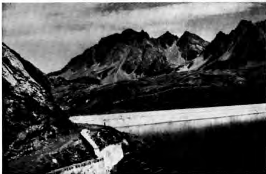
Foto 1. Il bacino digato del Lago Kastel nel settembre del 1954, quasi al livello di massimo invaso; in primo piano lo sfioratore (cfr. tav. I, no 1)
