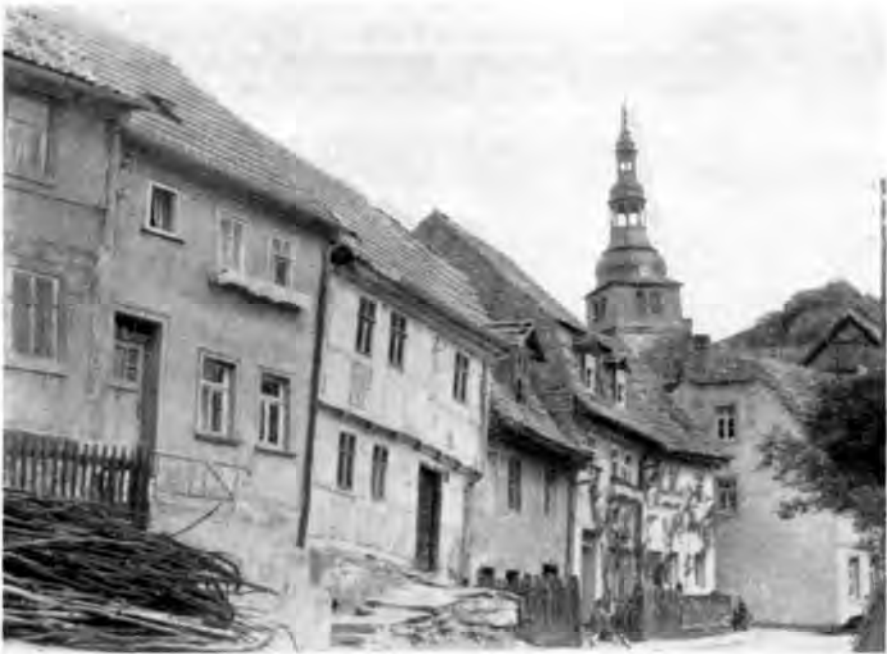
Abb. 1. Schiefstellung von Häusern infolge von Gleitungen in Erdfallzonen (Bad Frankenhausen)
