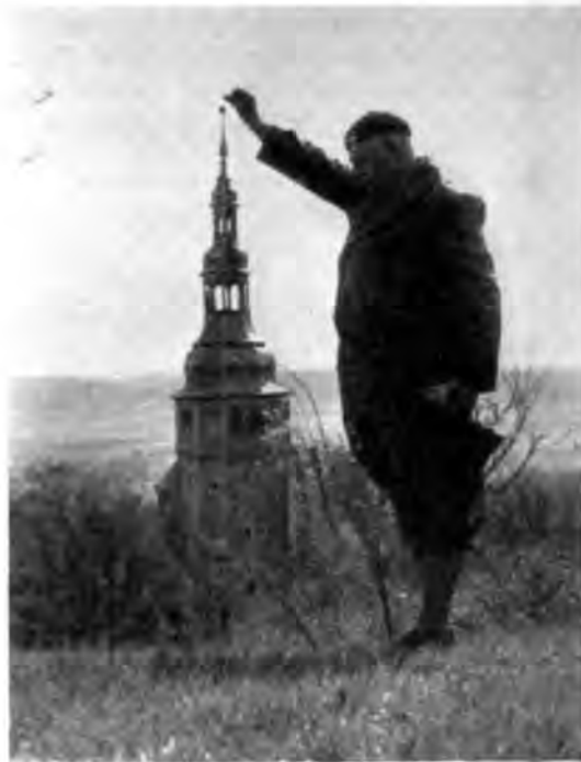
Abb. 2. Schief gestellter Kirchturm von Bad Frankenhausen im Zusammenhang mit Suffosionserscheinungen über verkarstendem Gips (Foto Kammerer)
