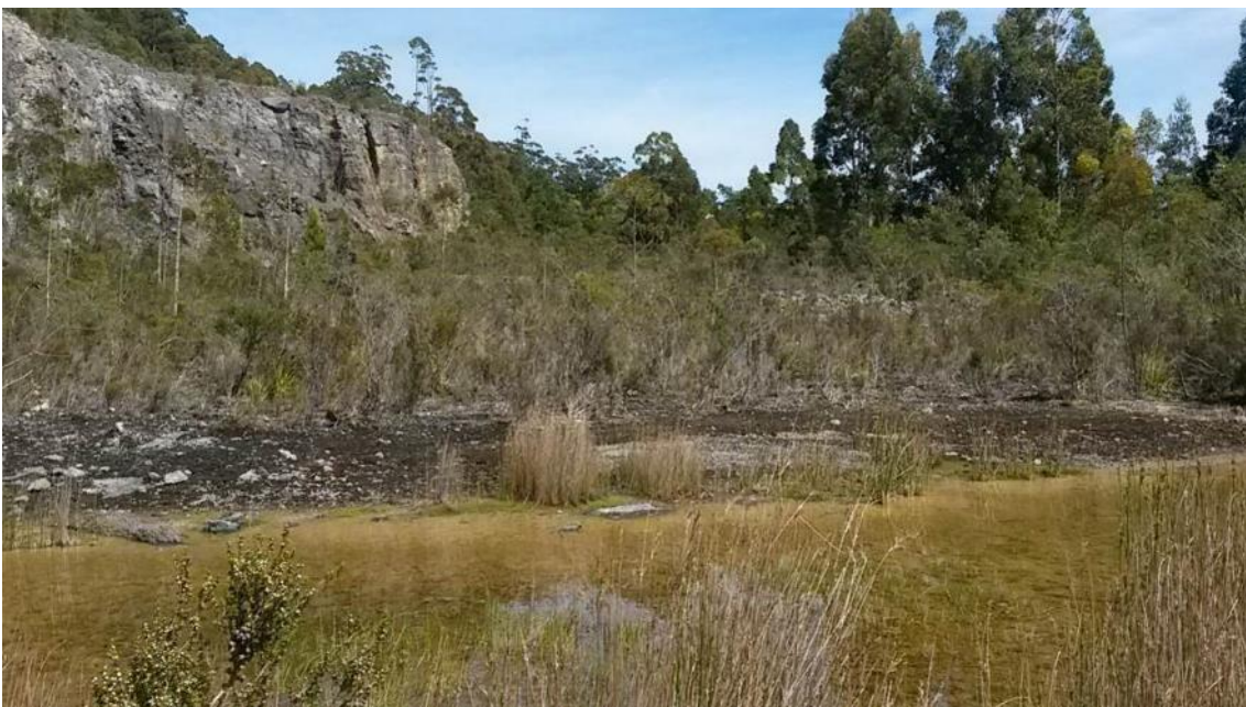
Pedreira de calcário reabilitada após vinte anos, Tasmanian Wilderness World Heritage Property. Durante a reabilitação, a pedreira foi subdividida em várias pequenas bacias de drenagem fechadas, cada uma com um sumidouro cárstico ou zona de infiltração como foco. Cada pia foi protegida por uma estrutura de filtro, e as áreas sob leques de argila tiveram estruturas adicionais instaladas para limitar o movimento de sedimentos após a chuva. Em seguida, será realizada a hidromassagem e a revegetação cuidadosa. Foto de David Gillieson.
