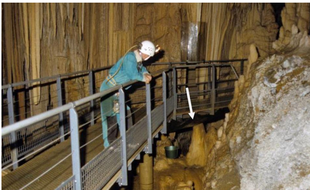
Uma passarela elevada na caverna turística Gouffre d'Esparros, França. A seta indica uma rede usada para fornecer proteção extra e evitar que sedimentos caiam nos espeleotemas abaixo. Foto de John Gunn.
