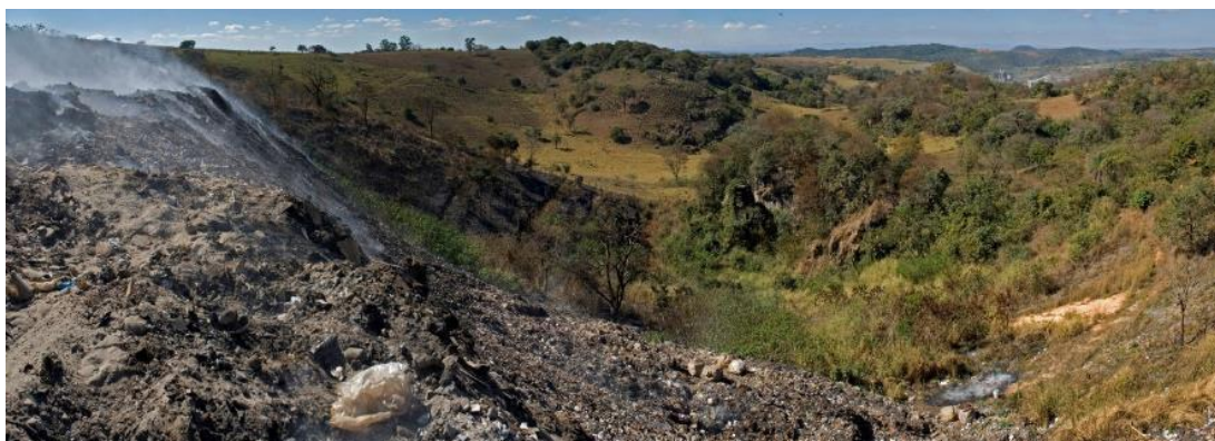
Aterro construído de forma inadequada no Carste de Lagoa Santa, Brasil. Foto de Luciana Alt.
