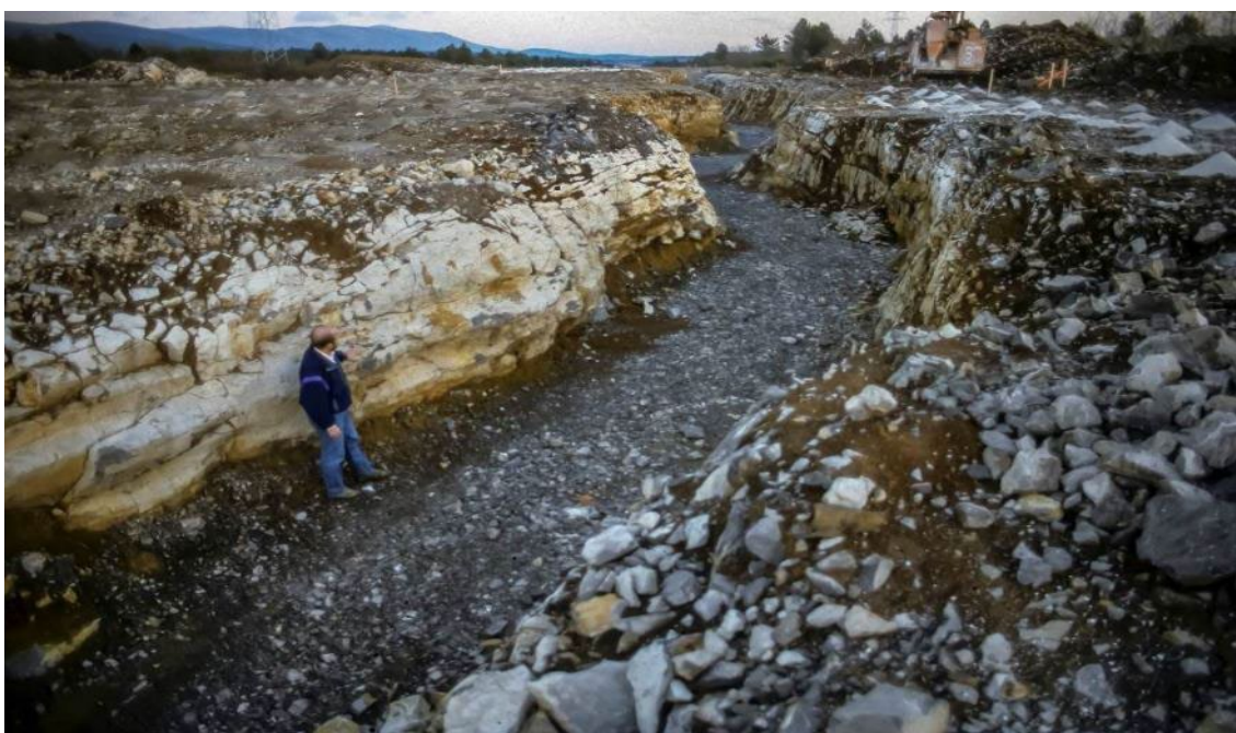
Traseul aceleiași autostrăzi din Slovenia trece peste ceea ce a fost inițial o peșteră fără tavan umplută cu sedimente. Cooperarea dintre constructori și Institutul de Cercetare a Carstului din Postojna a asigurat documentarea atentă a peșterii înainte de a fi umplută cu agregat și sigilată pentru reducerea riscului de prăbușire. Foto John Gunn.
