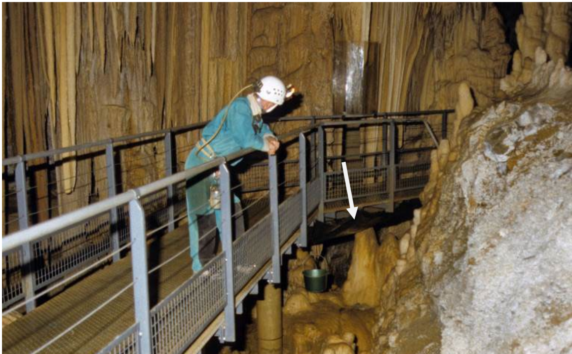
O pasarelă înălțată în peștera turistică Avenul d'Esparros, Franța. Săgeata indică o plasă care oferă protecție suplimentară și previne căderea prafului pe speleotemele de dedesubt. Foto John Gunn.
