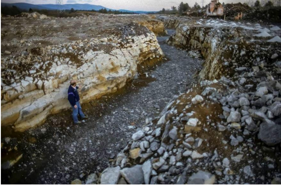
Ang ruta sa samang motorway sa Slovenia nag-agi ibabaw sa orihinal nga napunog linugdang nga walay atop nga langob. Ang kooperasyon tali sa mga konstruktor ug sa Karst Institute sa Postojna nagsiguro nga ang langob maampingong gidokumento sa wala pa mapuno sa aggregate ug gitakpan aron makunhuran ang peligro sa pagkahugno. Litrato ni John Gunn.
