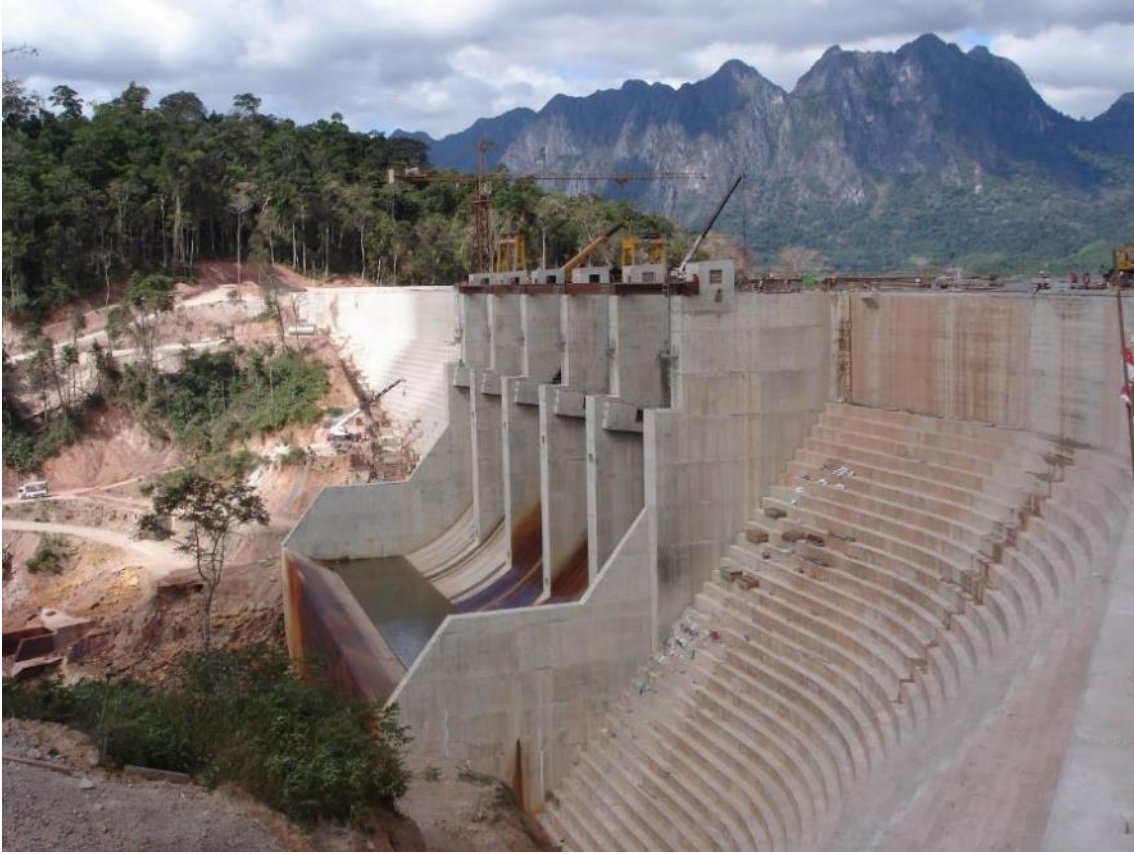
Hydropower dam nga gitukod sa karst terrain, Laos. Litrato ni Terry Bolger.
