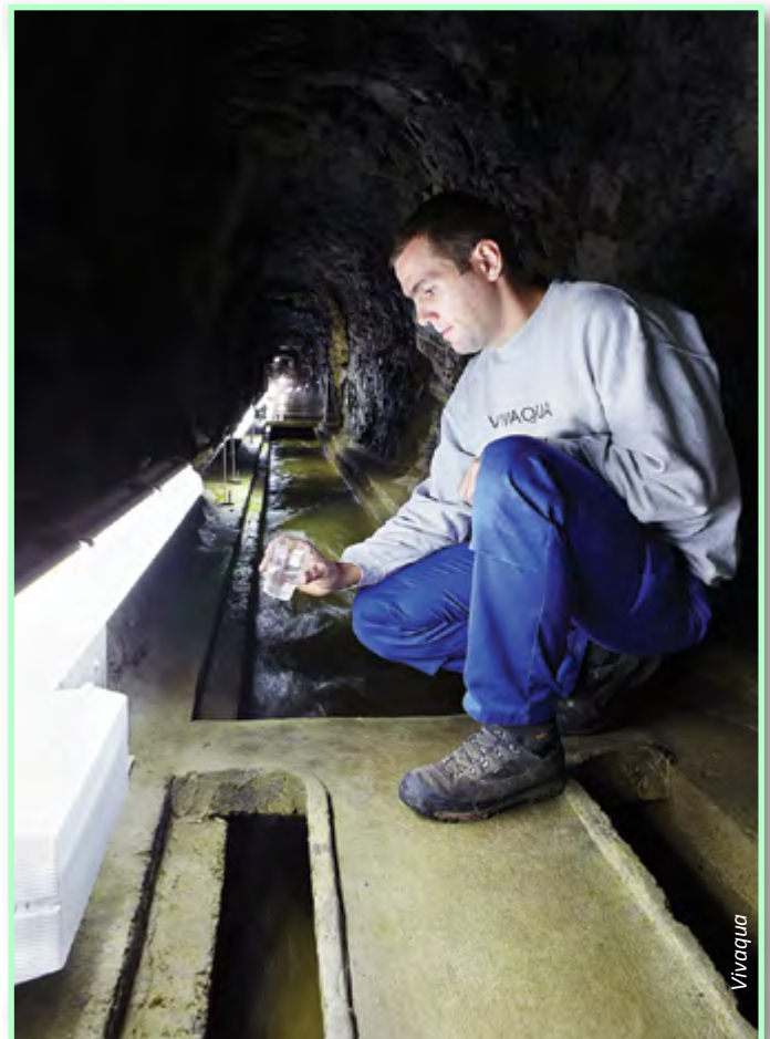
Fig. 02. Vaste galerie drainante dont le réseau total dépasse les 4 km et qui sert de captage alimentant notamment la Ville de Bruxelles.
